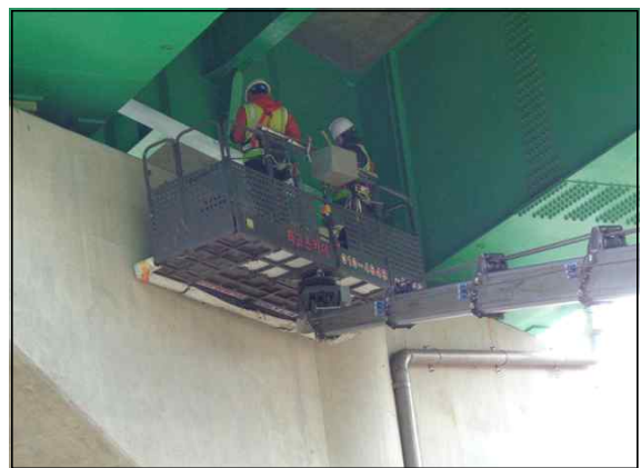
작업차량을 이용한 외관조사
