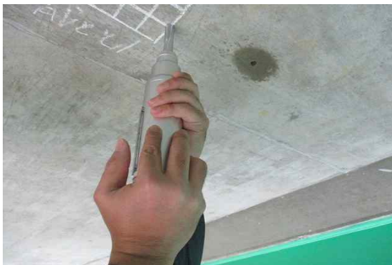
상부구조 바닥판하면 반발경도 측정
