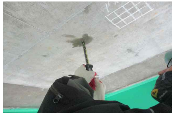
b. 바닥판하면 탄산화 시험
