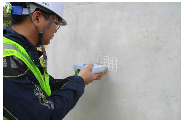
하부구조 교각 반발경도 측정
