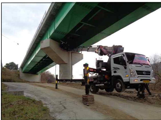
작업차량을 이용한 외관조사
